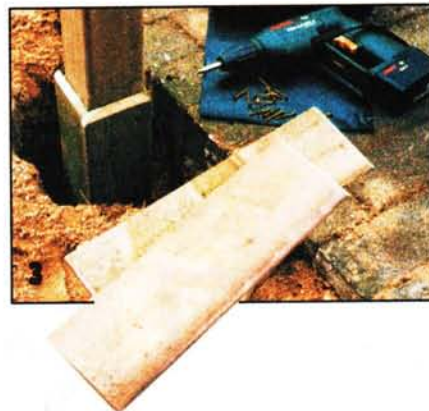
Выступающие края плёнки можно для красоты укрыть отрезками досок. Последние приворачивают шурупами к стойке.
