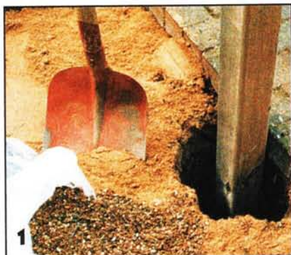
После установки стойки яму лучше заполнить не вынутым грунтом, а гравием.
